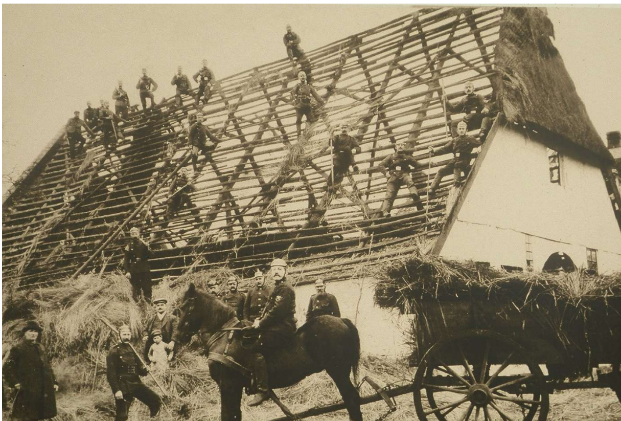
Der Abriss des Warnkeschen Hauses durch die Feuerwehr
