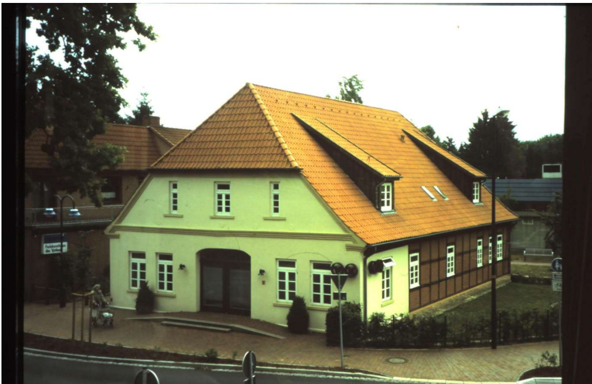
Nach den aufwändigen Arbeiten im Auftrag der Volksbank
