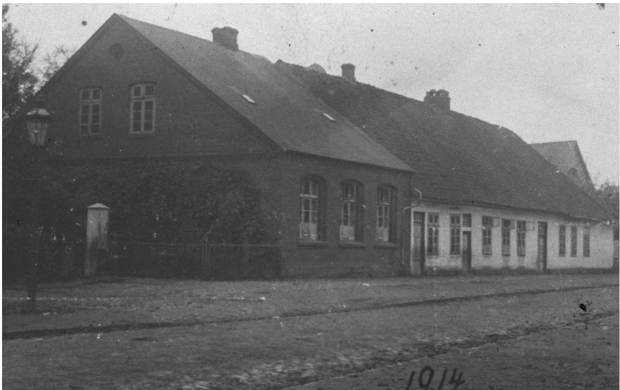
Die Wirkungsstätte des Lehrers Lührs, Die Schule von 1790 stand auf dem Marktplatz und wurde mehrere Male erweitert, Bis 1915 das neue Schulgebäude bezogen werden konnte.
